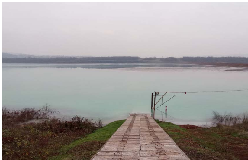
Slika 9. Deponija sa mjernom opremom
