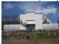
Slika 10. – Izgled bočne strane bunkera za utovar uglja (iz dvije pozicije) uz koju su izgrađene apsorbirajuće barijere za zaštitu od buke naseljenog područja
