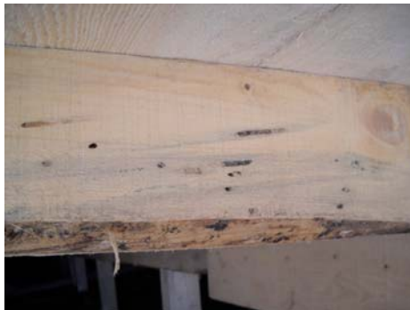
Slika 4. Upotreba vanstandardne drvene građe
