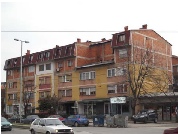
Slika 1. Nadgradnja od dva nova sprata na postojeći objekat od dva sprata
