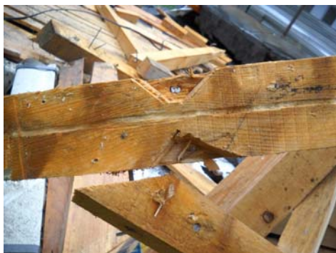
Slika 5. Gruba obrada i oslabljivanje nosećih greda zbog "kratkoče" eksera
