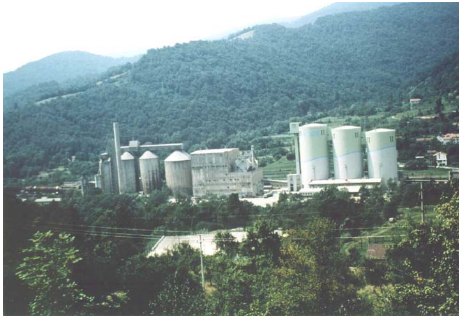
Slika 5: Konačni izgled saniranih silosa za beton
